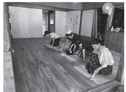
写真8 調合塗料での床塗装
