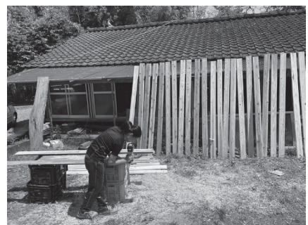
写真4 乾燥させた板をさね加工する
