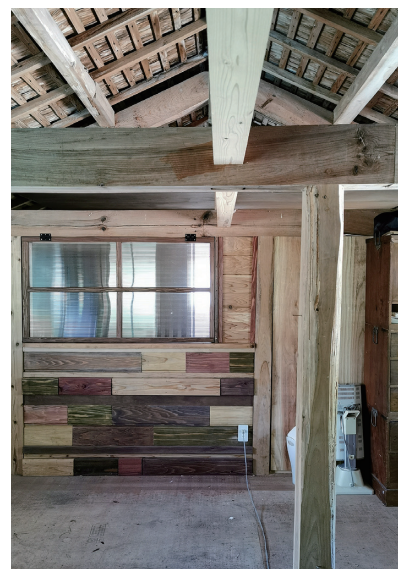
コミュニティ大工と建て主が協働で製作した納屋の間仕切り壁。数カ月現場を経験すると大抵の不具合は自力で解消できる
