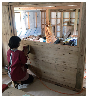
間仕切り壁を施工する建て主。作業通じてコミュニケーションを図る
